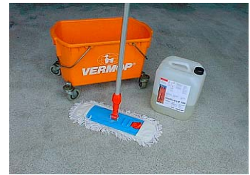
Auftragen der Einpflege StoDivers P 110 mit einem Wischmop.
